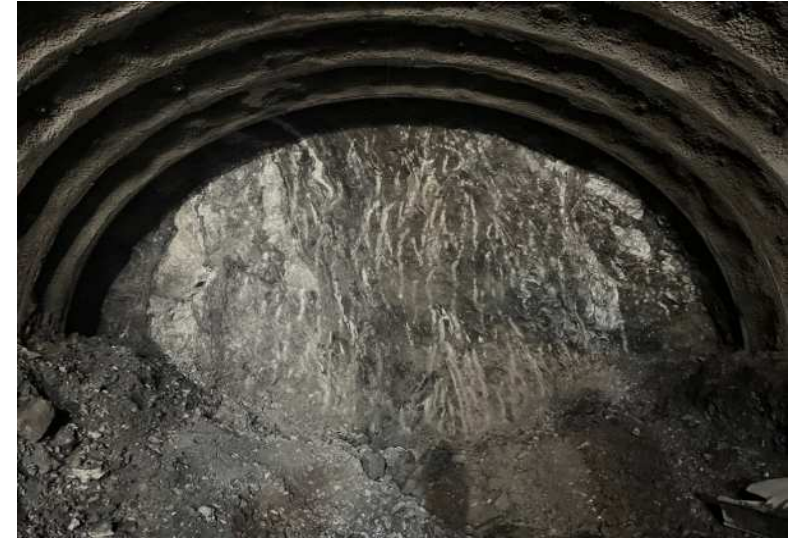
トンネル掘削 1800m付近の岩盤の状況です。比較的安定しています。
