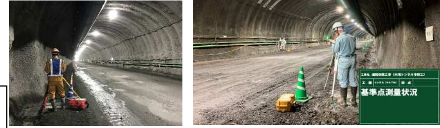
測量状況 トンネルの管理で一番重要な、基準点の確認をしています。定期的に測量専門会社とダブルチェックを行い無事貫通できる
