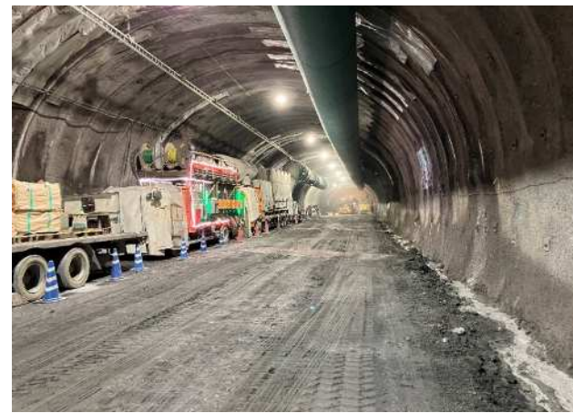
覆工 標準断面部が437m進みました。右写真は非常駐車帯（故障車等が退避する場所）取合い部を施工している所です。
