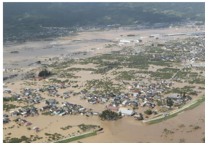
長野県長野市 千曲川 (令和元年東日本台風) 令和元年10月31日
