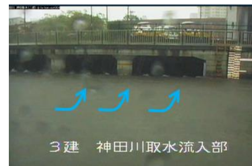
神田川・環状七号線地下調節池への流入状況
