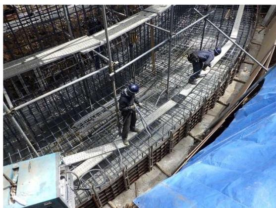
施工中(逆 T 式擁壁工)
