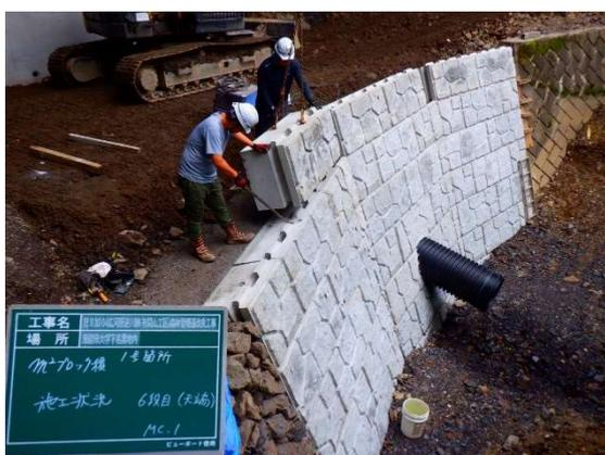
施工中 (大型ブロック積工)
