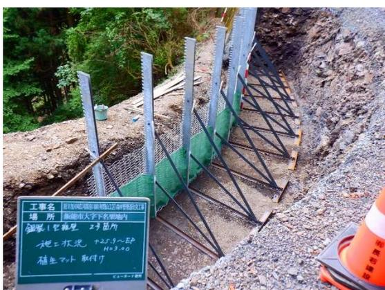
施工中 (鋼製 L 型擁壁)
