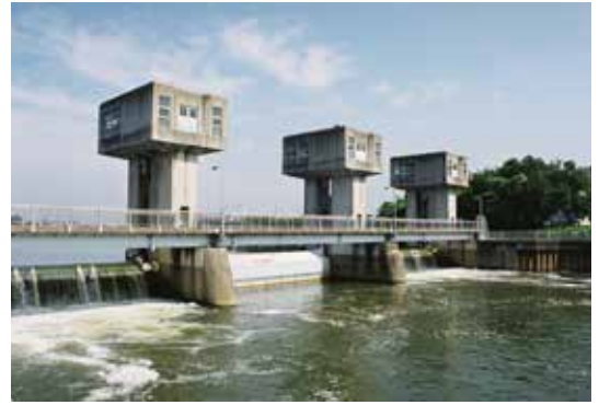
▲堰で河川の水位を上げて取水
