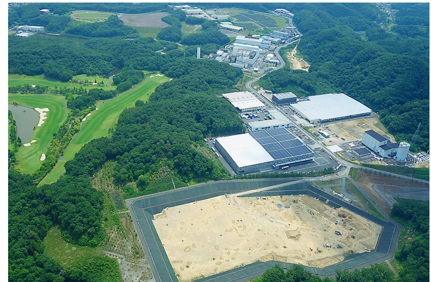
写真4-2 彩の国資源循環工場
