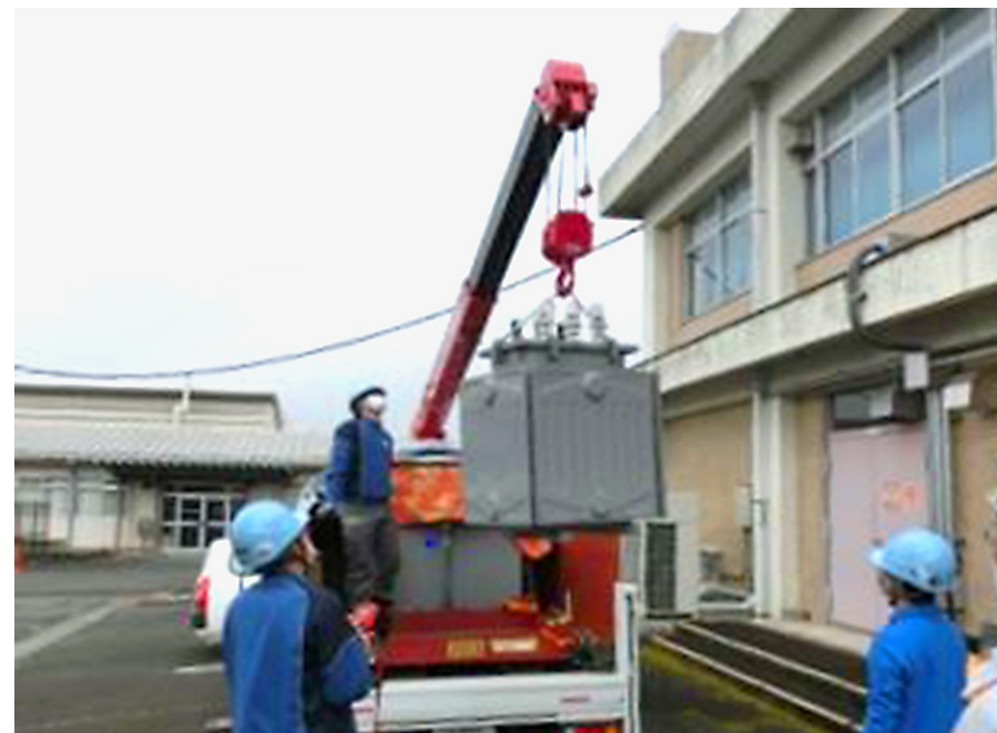
写真5-2 PCB廃棄物（PCB含有変圧器の運搬処理）
