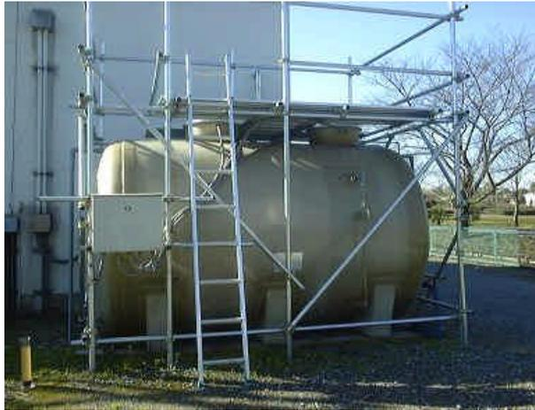
図1 畜舎排水低曝気処理装置
