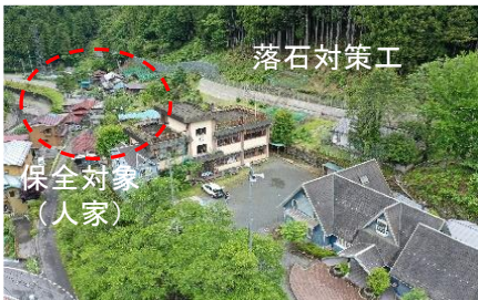
砂防関係施設整備
