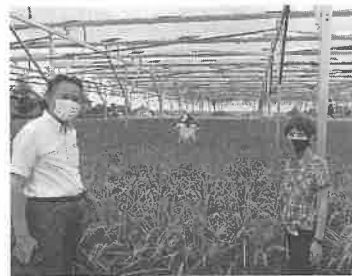
加須市内の営農型太陽光発電所
