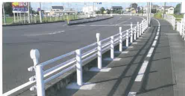
▲令和3年9月 県道川越北環状線 平塚橋東
