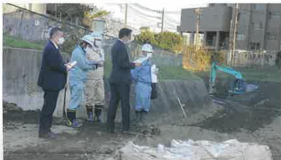
▲令和3年12月15日 南小畔川緊急浚渫工事が行われ 県職員、水利組合の皆様と現地調査
