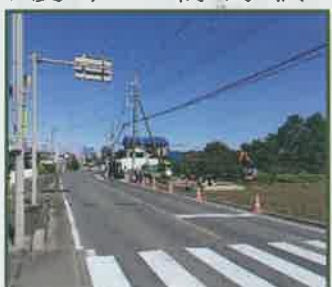
路側帯設置工事と横断歩道の整備が進む県道川越栗橋線
