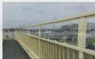
上部を透明板にした「こかわ歩道橋」
