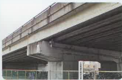
●深谷中央陸橋 深谷嵐山線 橋りょう修繕・断面修復
