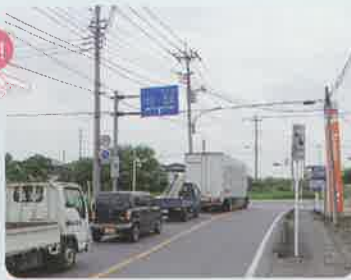
●田中交差点付近 深谷嵐山線 道路改築
