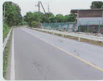
●本田小川線 舗装道整備
