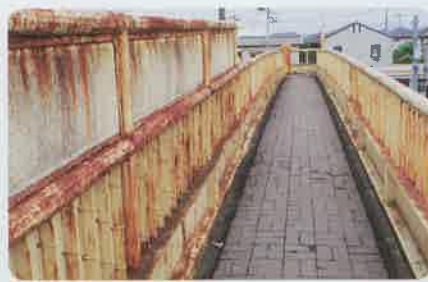
●桜ヶ丘歩道橋 深谷嵐山線 橋りょう修繕・塗装塗替
