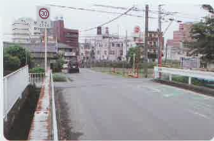
●西島踏切り付近 深谷寄居線 自転車歩行道整備
