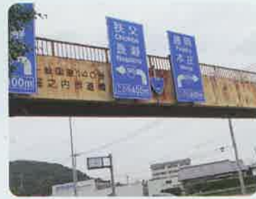
●堀之内歩道橋 国道140号(桜沢) 橋りょう修繕・塗装塗替
