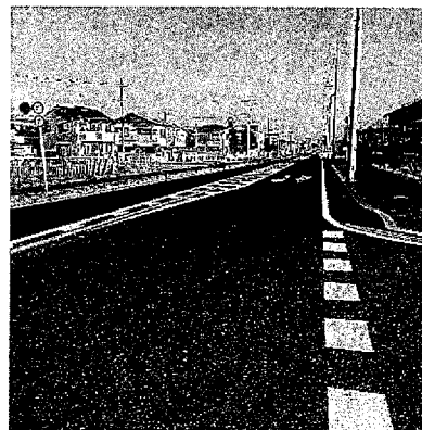
舗装を打ち換え、凹凸をなくした「県道六万部久喜停車場線」
