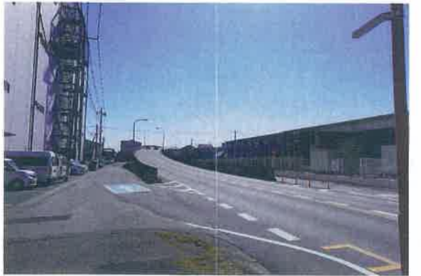
加須市が整備した東武鉄道を渡る立体交差「花崎陸橋」
