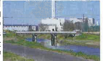
河川改修整備が進められている大利根地域の古門樋橋
