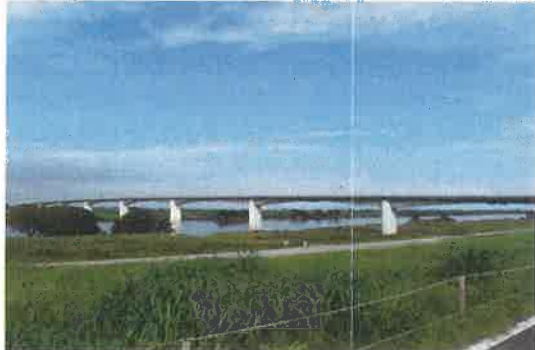
昭和47年に供用開始された埼玉大橋
