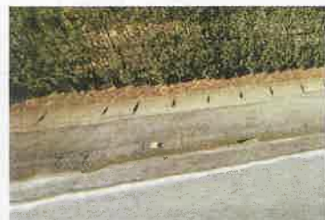
▲現在の状況。歩道の再整備が進められています。
