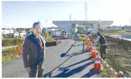
▲本庄道路を南北に交差する市道1305号線の箱型函渠工の整備も順調に進んでいます（沼和田地区）。
