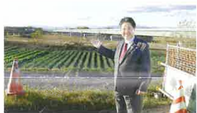
▲「新神流川橋」は、令和4年内の完成（暫定2車線での供用）に向け工事が急ピッチで進められています。
