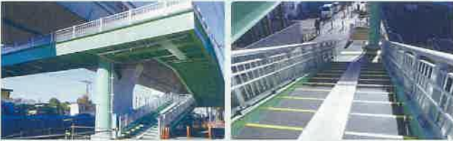
西堀横断歩道橋は新しく架け替えられたことで、自転車も渡れるようになり、利便性が向上しました。
