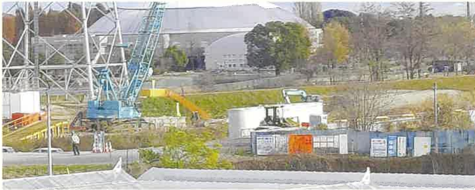
▲シルクドーム西側の花園本庄線工事の様子。
