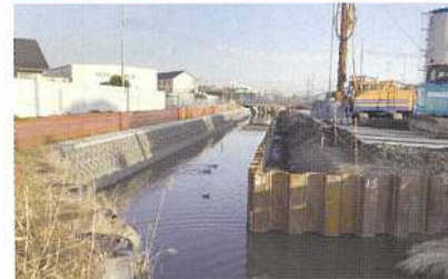
第二大場川の護岸工事・市道橋架け替え工事
