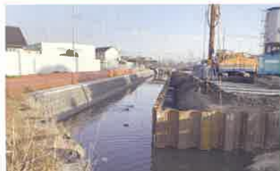
第二大場川の護岸工事・市道橋架け替え工事
