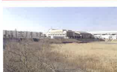
新和小学校北側調節地の樹木伐採
