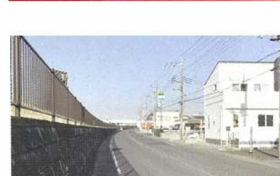
葛飾吉川松伏線(花和田付近)の舗装整備
