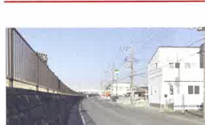
葛飾吉川松伏線(花和田付近)の舗装整備
