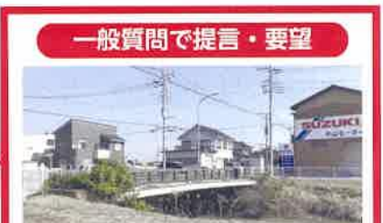
小谷堀橋架け替えに伴う借地使用料・迂回路工事・用地買収・物件補償・架け替え工事
