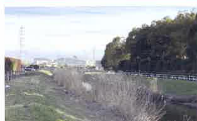
第二大場川の茂沢橋北側付近の河道掘削工事
