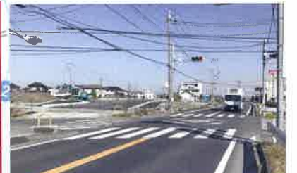
三郷松伏線新設に伴う旧道移管の工事
