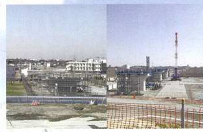
(仮称)三郷流山橋の工事委託
