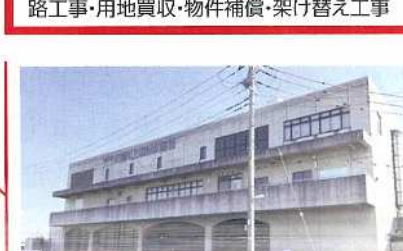
大場川上流排水機場の躯体の耐震化工事・ポンプ設備整備工事・保守点検修
