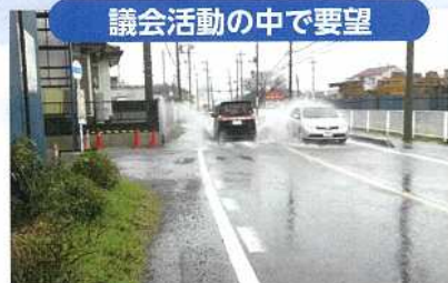
越谷流山線の側溝新設
