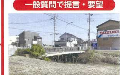
小谷堀橋架け替えに伴う借地使用料・迂回路工事・用地買収・物件補償・架け替え工事
