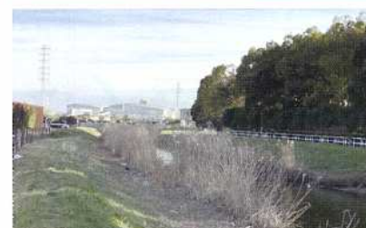
第二大場川の茂沢橋北側付近の河道掘削工事
