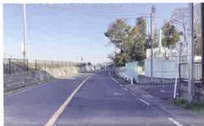
葛飾吉川松伏線(上口付近)の舗装修繕
