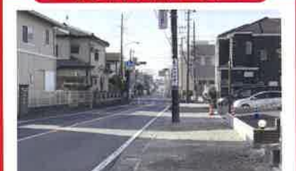
三郷松伏線の歩道整備に伴う用地補償・工事
