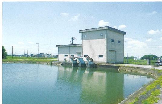
▲揚水機場の調整池とポンプ場 （権現堂第 4 揚水機場）
