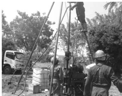
写真 ボーリングの様子
