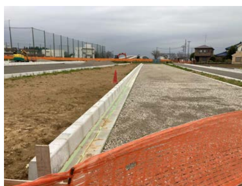
国道254号バイパス 志木工区
