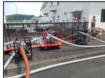
(排水ポンプ設置)
