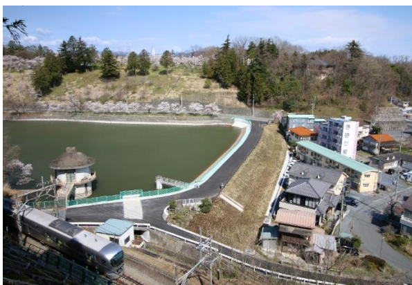
堤体の下流に住宅や道路が近接するため池（姿の池・横瀬町）
