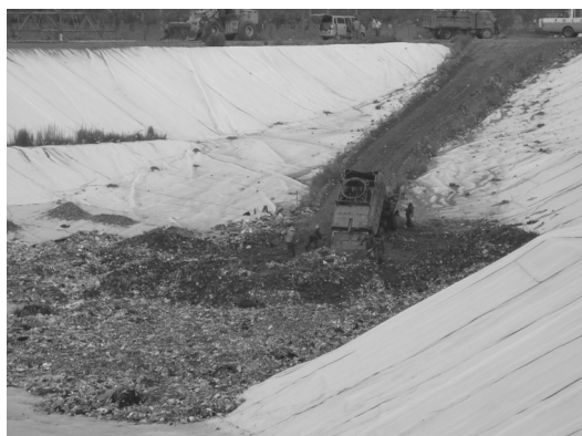
新規整備処分場における埋立の様子
