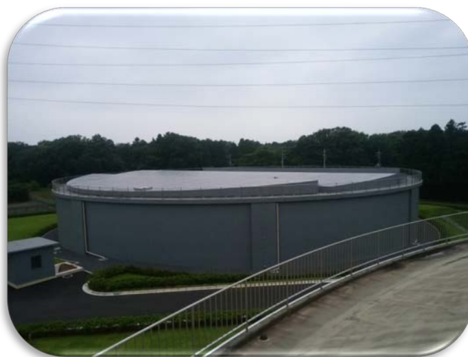
上赤坂中継ポンプ場備蓄施設
