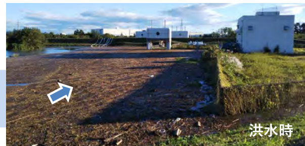
飯盛川最下流部(越辺川合流点)溢水状況
