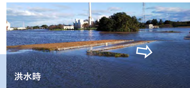
飯盛川(坂戸市道:荻野2号橋)溢水状況
