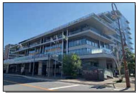
<川口市役所第一本庁舎>
