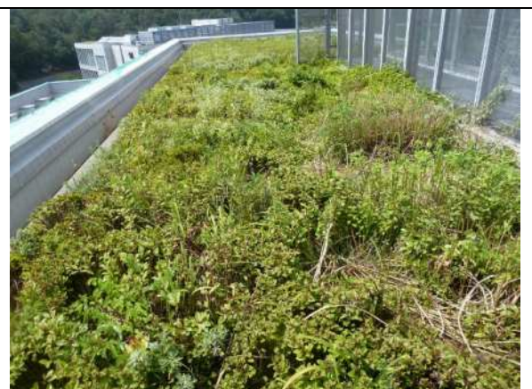
屋上緑化状況（株式会社カインズ） (2021/7/30 撮影)
