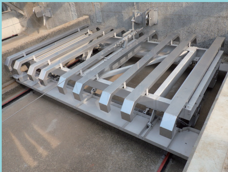
■大久保浄水場西部系1B汚泥掻寄機更新工事（令和3年3月完成）
