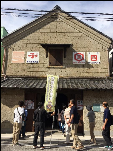
小川現右衛門蔵 昭和7年築造 大谷石石組積造2階建て
