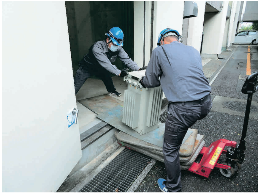
写真5-2 PCB廃棄物（高圧変圧器の運搬処理）
