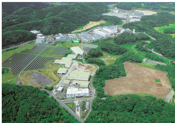
写真4-1 彩の国資源循環工場
