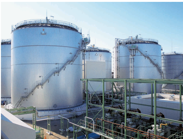
写真1-1 中川水循環センターの消化槽
