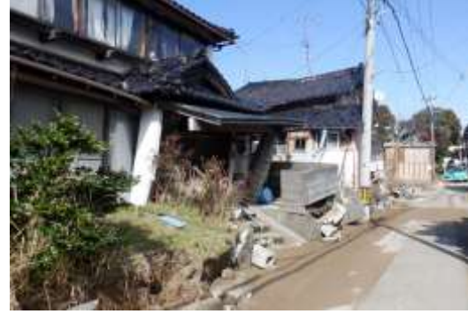
電柱に衝突し歪んだ建物
