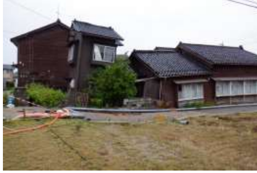
段差で変形した建物
