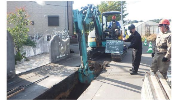
汚水の管渠工事
