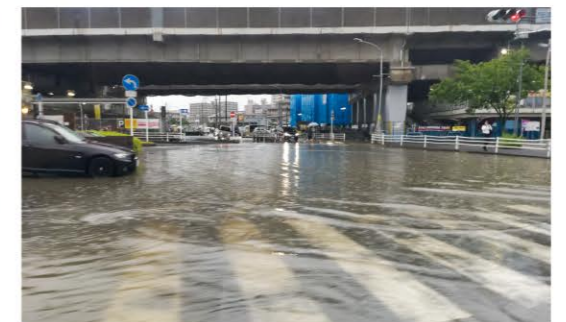
内水による被害
