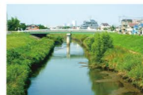
下水道整備後の川
