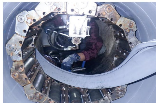
管渠の補修工事
