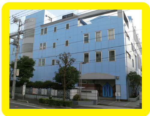
⑫ 校舎北側(西川口陸橋通り沿い)
