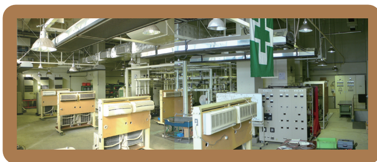
⑦ 実習室 屋内配線工事や電気制御配線、空調設備の取付けなどを学ぶ設備類
