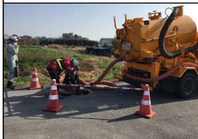
吸引車による汚水の移送
