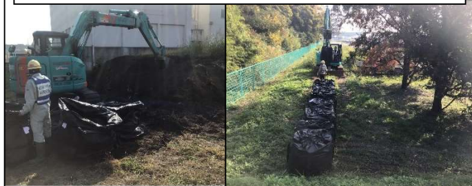
土嚢の作成・設置
