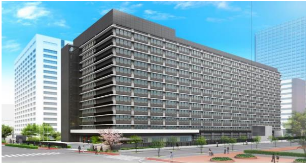
新庁舎外観 (地上13階、地下2階)
