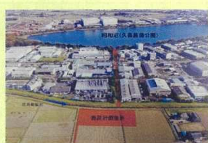
上空から見たパイプライン埋設予定地等
