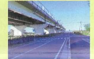
県道5号と圏央道側道交差点
