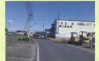
L字溝の工事を進めている上栢間の県道行田蓮田線
