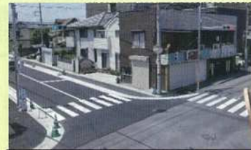
久喜中央交差点を整備し信号機を設置した後
