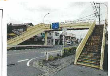
老朽化が進み修繕工事を行う県道川越栗橋線の「仲町歩道橋」
