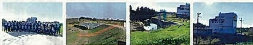
越辺川決壊箇所
