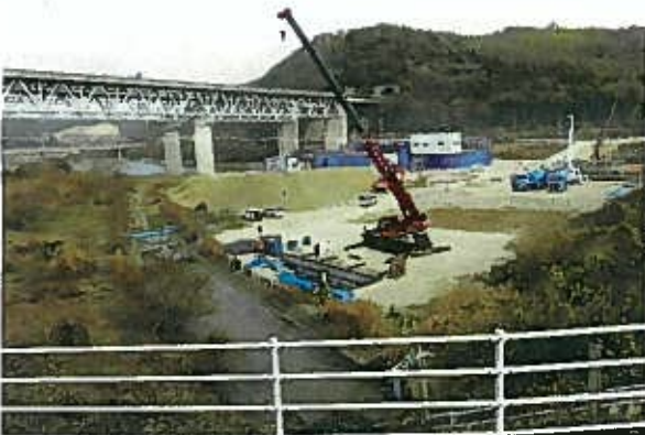
▲河川改修工事が進む現地
