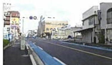
▲無電柱化の実施状況(川口上尾線)
