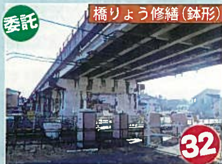
傷んだ橋を補修します (国道254号・鉢形陸橋)
