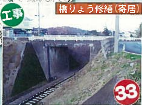
橋のひび割れの補修を行います (飯能寄居線・八高陸橋)
