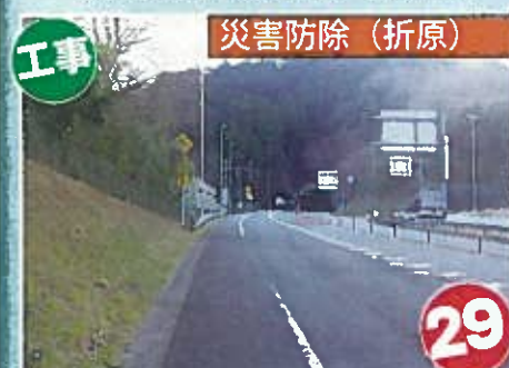
工事 災害防除(折原) 安全に通行できる道路を作ります(国道140号)
