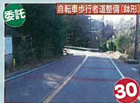
歩道の整備を行います (坂本寄居線)
