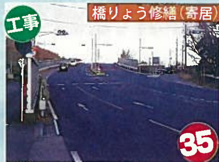
傷んだ橋のひび割れ補修をします (国道140号・寄居陸橋)
