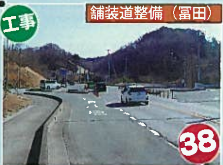
傷んだ舗装を修繕します (国道254号)
