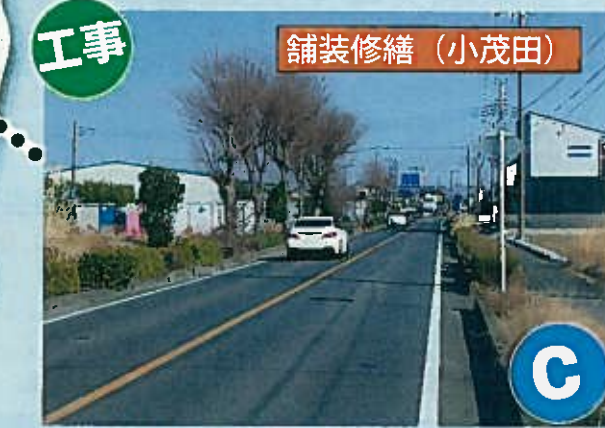
傷んだ舗装を修繕します (蛭川普濟寺線)
