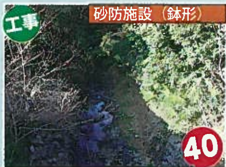
溪流保全の工事を行います (関山川)
