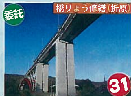
補修設計を行います (国道140号・折原2号橋)
