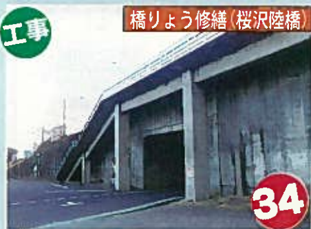
傷んだ橋のひび割れ補修をします (国道140号)
