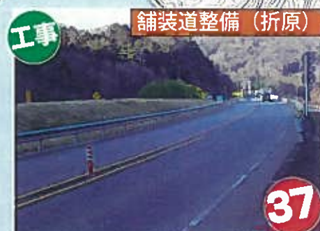
工事 舗装道整備(折原) 傷んだ舗装を修繕します(国道140号)
