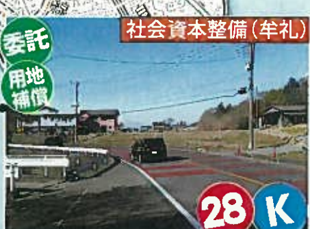
安全に通行できる道路を作ります (赤浜小川線)
