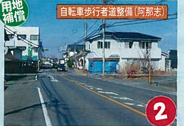
安全に通行できる歩道を作ります (本庄寄居線)
