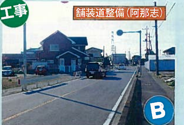
傷んだ舗装を修繕します (熊谷児玉線)
