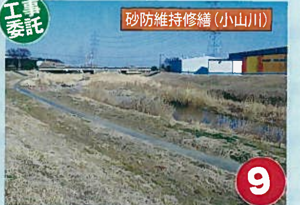
護岸の修繕などを行います
