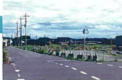
秩父鉄道の北側、県道深谷嵐山バイパス線の計画場所
