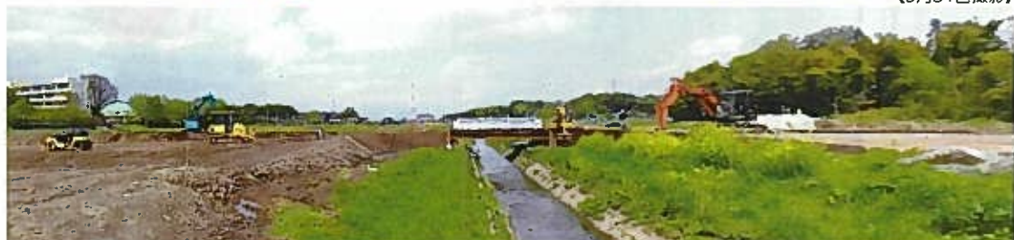
▲写真は4月22日に撮影した工事の様子。道路(市道3213号線)をかさ上げして桶川西中学校南側の江川を渡る橋を広くして架け換えをするという事で、そのため通行に影響がないよう、迂回用道路(橋)の建設工事が進められていました。
