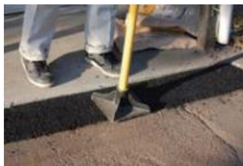
上から転圧します
