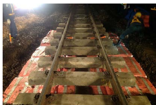
施工例 4：鉄道噴泥対策と振動低減
