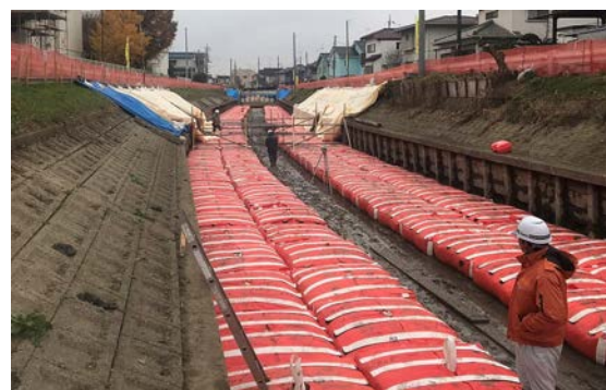
施工例 3：水路工事 地盤補強
