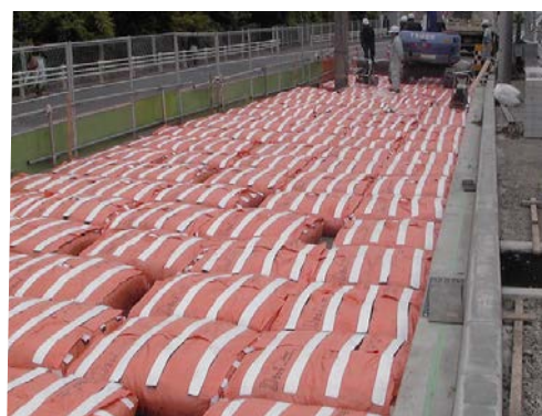
施工例 2：道路 振動対策
