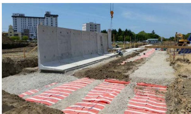
施工例 1：擁壁補強 液状化対策
