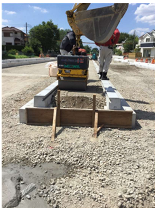
中央分離帯施工
