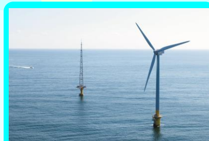
銚子沖洋上風力発電所
