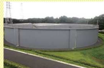
水道水の貯留タンク
