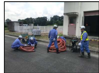
(排水ポンプ設置)
