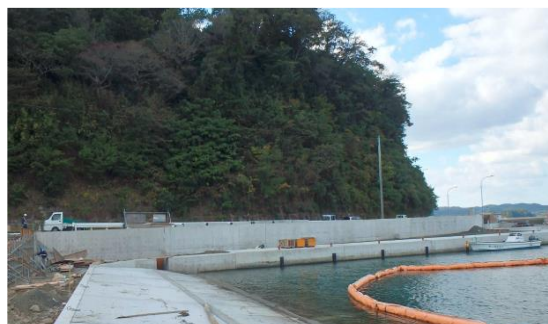
七ヶ浜町 船たまり 施工中
