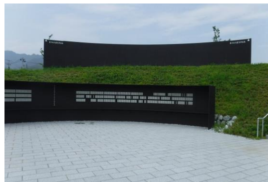
釜石祈りのパーク（東日本大震災慰霊碑） 黒いモニュメントは津波浸水高と同じ高さ
