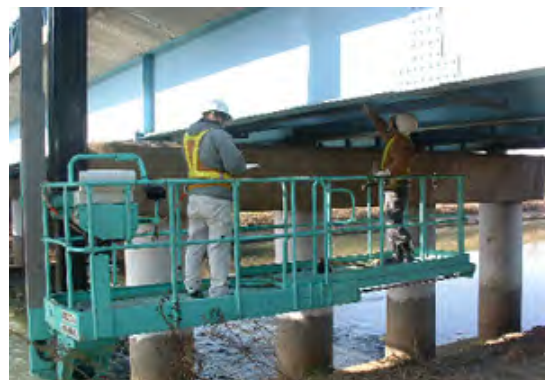
出典：埼玉県HP「埼玉県橋梁長寿命化修繕計画」
