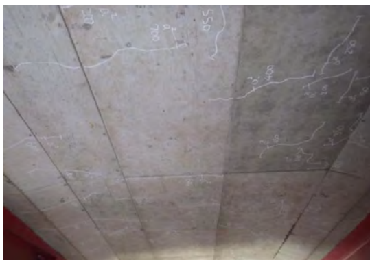
出典：埼玉県HP「埼玉県橋りょう保全計画」
