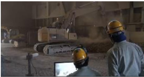
13 遠隔操作重機
