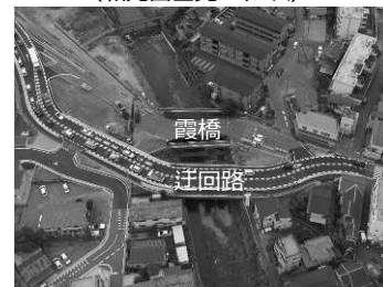
橋りょう架け替え工事 国道299号（霞橋）
